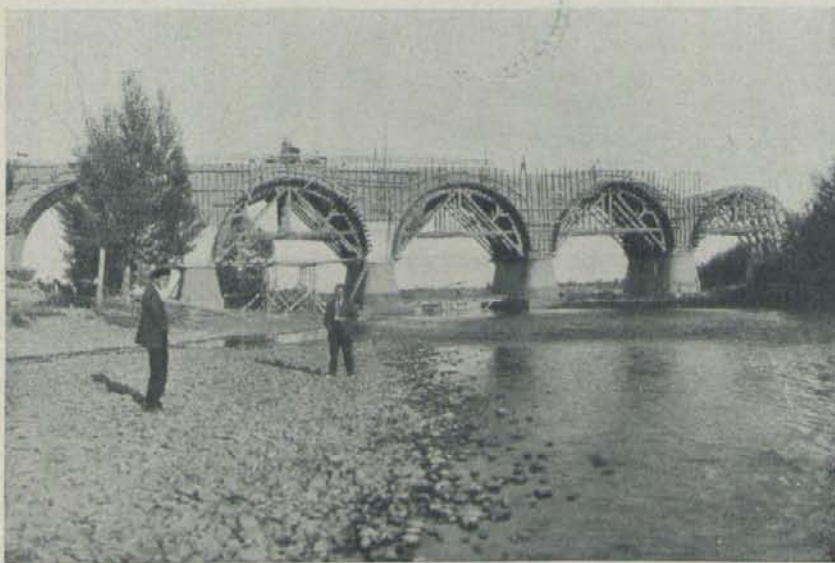
Puente del Burgos-Madrid, aguas abajo de Lerma, que cruza el río Arlanza.
