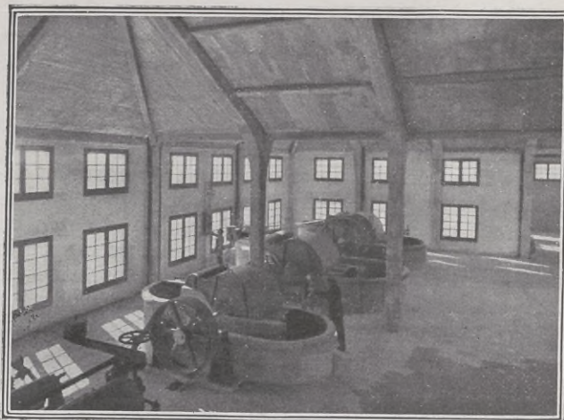
Sala de pilas.
