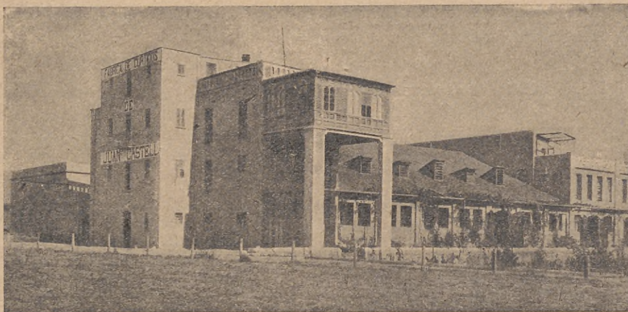
Vista exterior de la fábrica.
