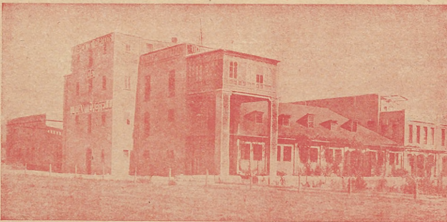
Vista exterior de la fábrica.
