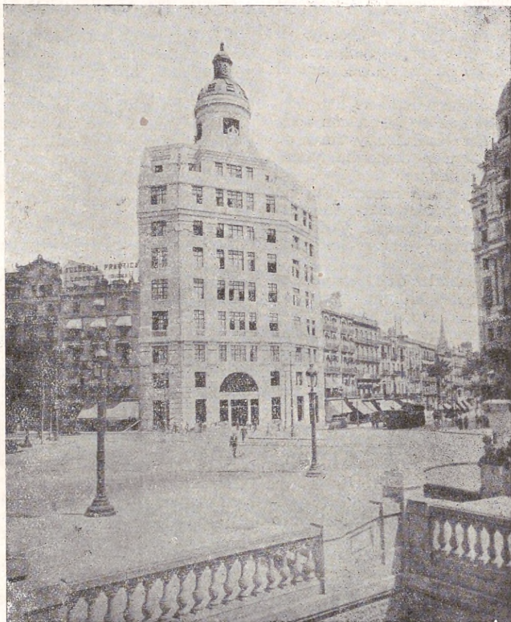
La central «Cataluña», de la Compañía Telefónica Nacional de España, ya terminada y funcionando
