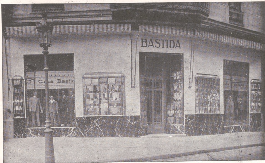
La nueva fachada de la «Casa Bastida», espléndida manifestación de arte y riqueza, decorada por la mejor casa de París, que adorna la esquina del Paseo de Gracia y calle Cortes
