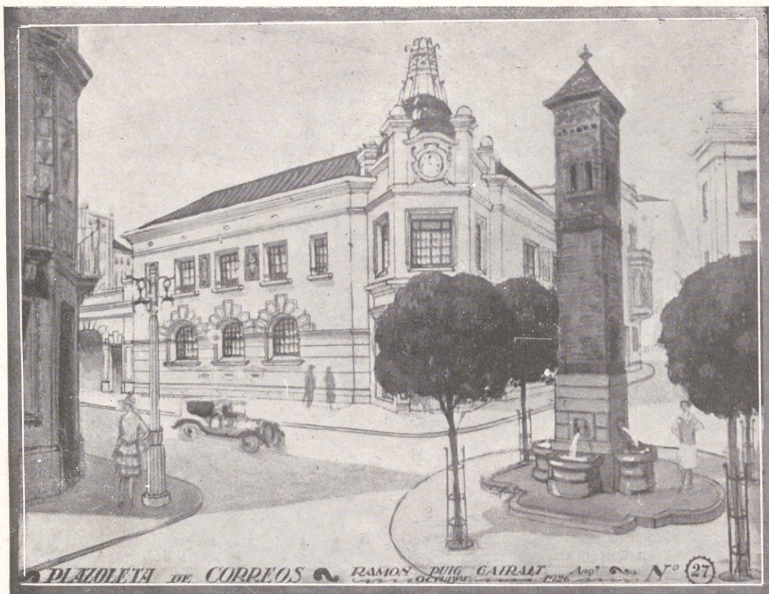
Edificio de Correos y Telégrafos, inaugurado recientemente por S. M. la Reina. — Proyecto del arquitecto Ramón Puig Gayral.
