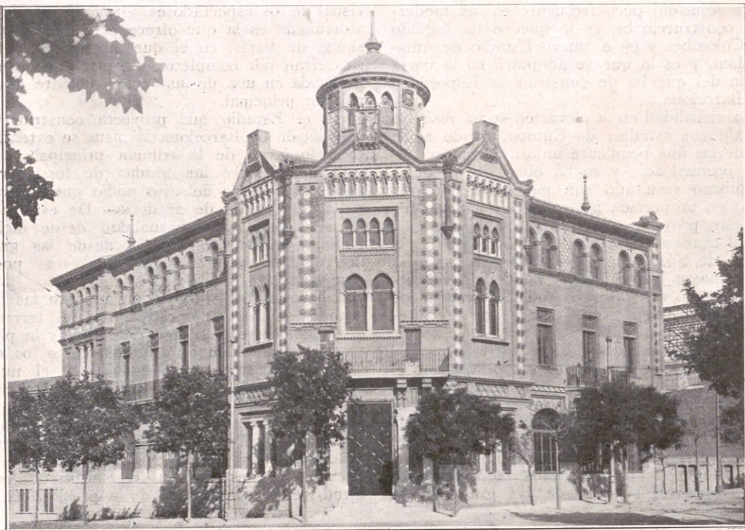
La Casa de la Prensa terminada. Vista general.
