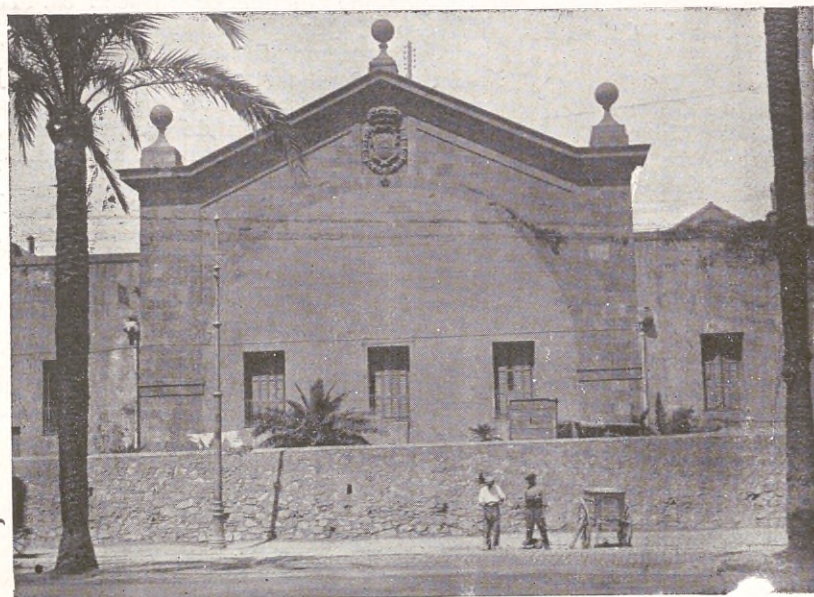
Estado actual del exterior de la gran arcada (hoy tapiada) del segundo canal de las tres naves del 1564, visto desde la actual Aduana. (Foto. A. Goitia).
