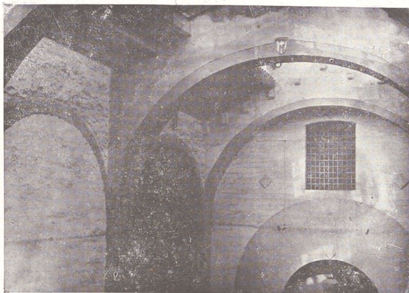
Detalle de la nave de entrada a la Maestranza de Artillería, cuya nave separa la parte más antigua de la más moderna de las seis naves de Arazanzas. En un arco se ve un escudo nobiliario en la actualidad. (Foto. A. Goitia).
