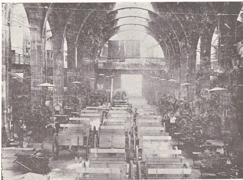
Estado actual de la gran arcada central de las tres naves más antiguas de Atarazanas. (Foto. A. Goitia).
