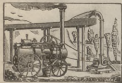
Bombas de vapor.
