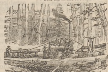
Máquinas de aserrar.
