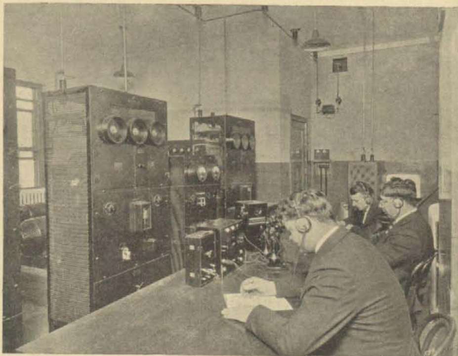
Sala de transmisión de WJZ y WJY. A la izquierda el aparato de transmisión de las letras de alarma SOS
