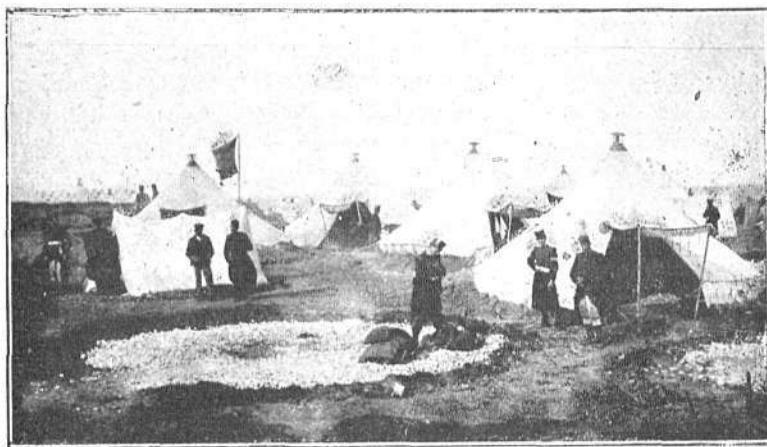
Campamento de la Restinga.
