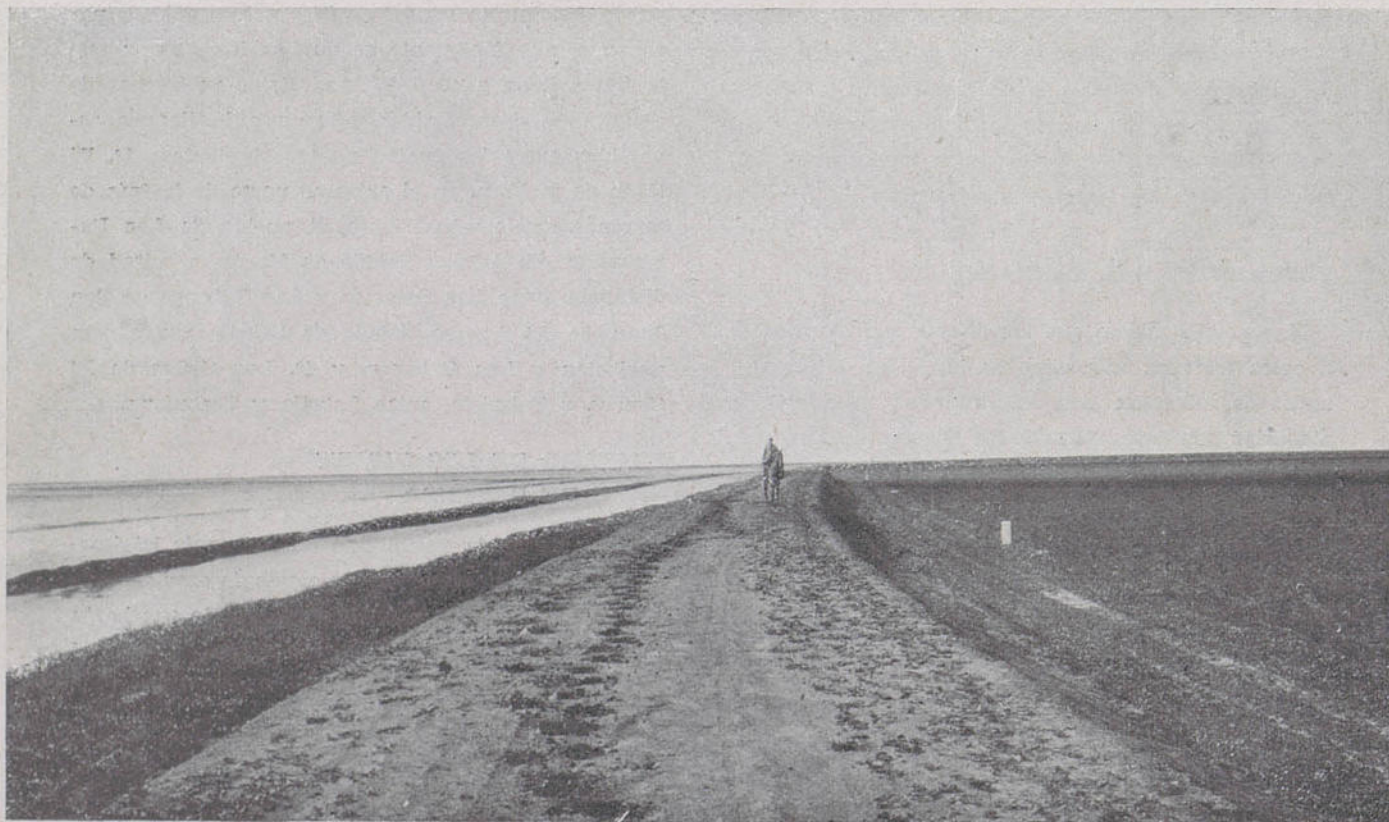
Un dique de defensa de la Sección primera. A la izquierda, terrenos exteriores a la sección, inundados. Abril, 1930.
