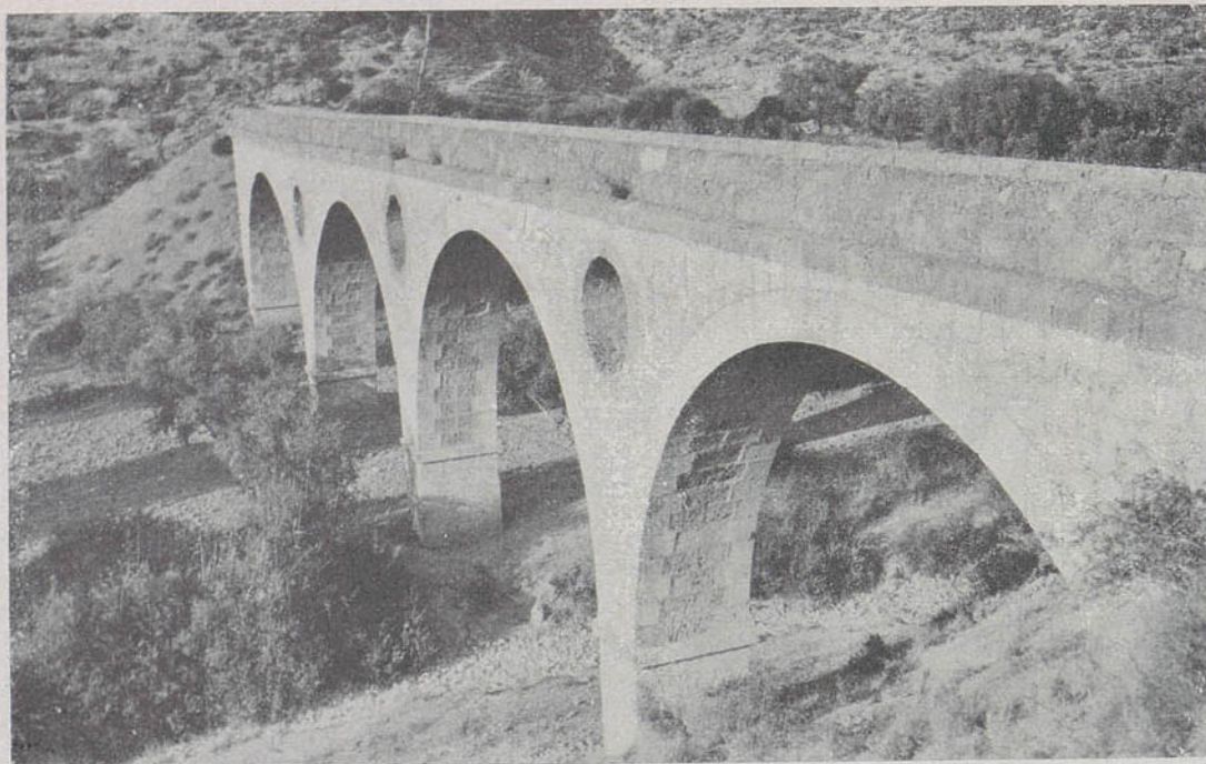
Acueducto sobre el río Blanco, construido hacia el año 1875.
