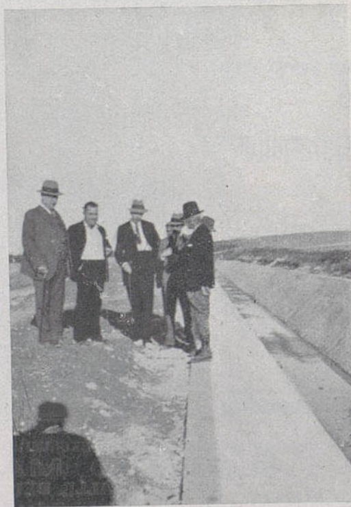
Canal del Genil. Trozo 2.º. Canal a cielo abierto.
