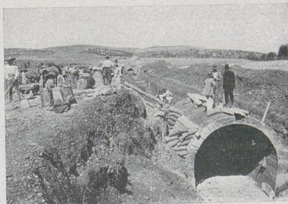
Canal del Genil. Trozo 1.º. Canal cubierto.
