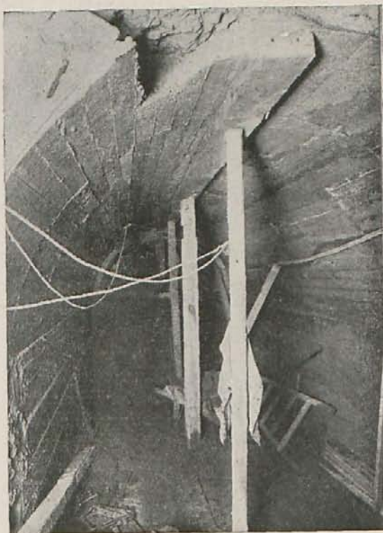
Una galería de saneamiento en la zona inferior del escenario.
