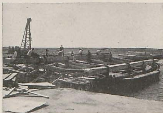
Fotografía (B).—Carga de los pilotes sobre gabarra.
