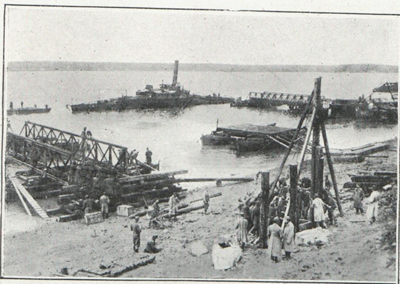
El paso del Danubio por Svistov.—Construcción del puente.
