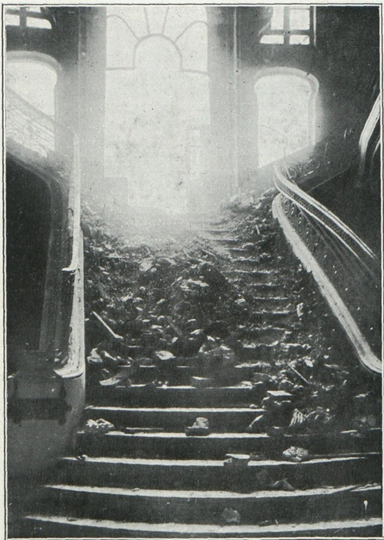
Constanza.—Destrozos causados por una bomba de un avión alemán, en el Casino.
