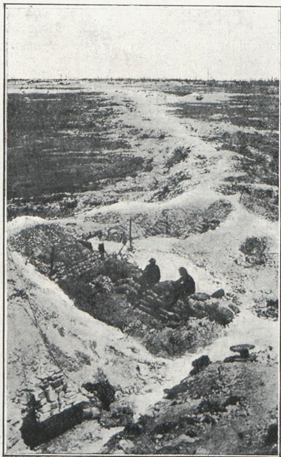
Trinchera tomada a los alemanes en Ovillers.
