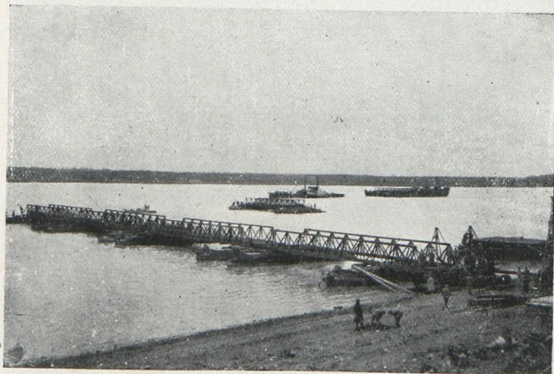
El paso del Danubio por Svistov.—Construcción del puente.
