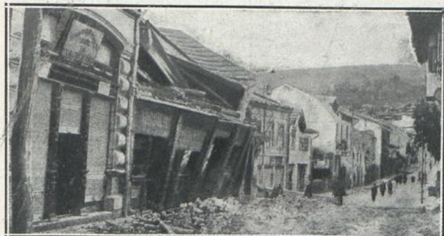
Un aspecto de Tirnovo después de la sacudida sísmica
