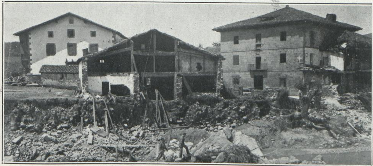
El puente de Errazu y casas derribadas por las aguas.—(Fotogs. Martín)
