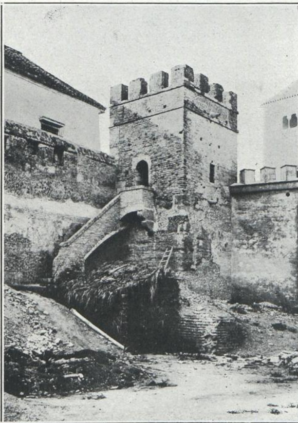
SEVILLA. —El torreón del Misterio de construcción romana que se está restaurando.—(Fotog. C. Olmedo)
