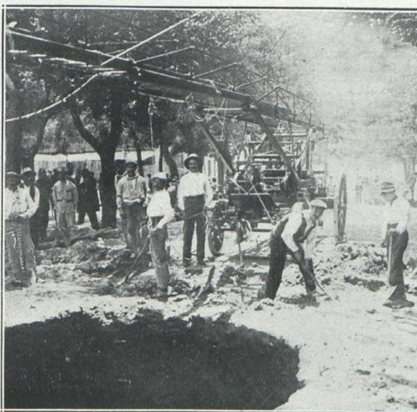
Los bomberos trabajando para extraer la máquina que se hundió en la calle de Embajadores
