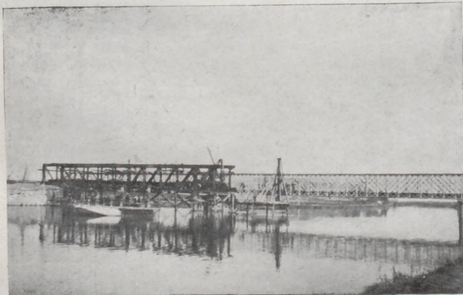
Puente sobre el Tajo construido por la casa de D. Pedro Lucas.
