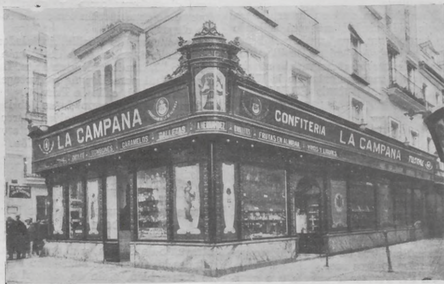
Exterior de la confitería "La Campana"
