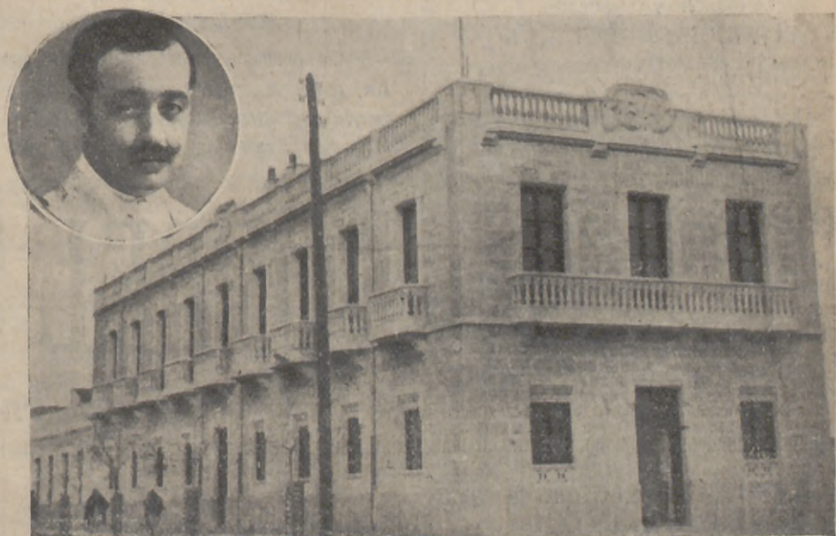
Casa-habitación construida en la calle del General Astilleros, con muros de mampostería y cubierta de cemento armado. En el círculo, D. Enrique Alvarez.
