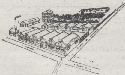
Fábrica de ascensores y montacargas en Madrid (Maudes).
