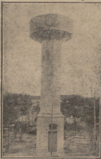
Nuevo depósito de agua de diez y ocho metros de altura y setenta mil litros de capacidad inaugurado recientemente en Carabanchel Bajo.
