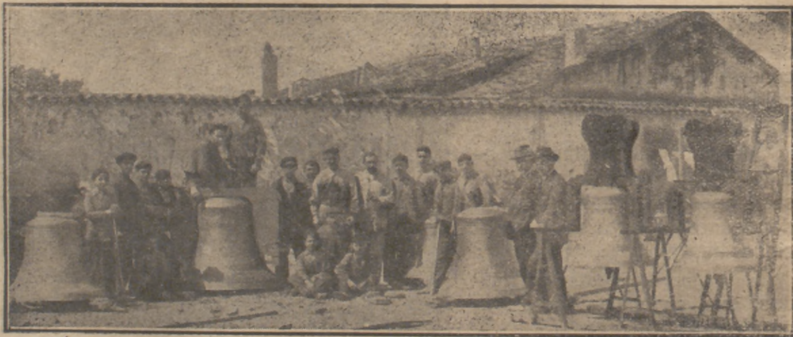
El Sr. Linares con un grupo de obreros en sus talleres de fundición.
