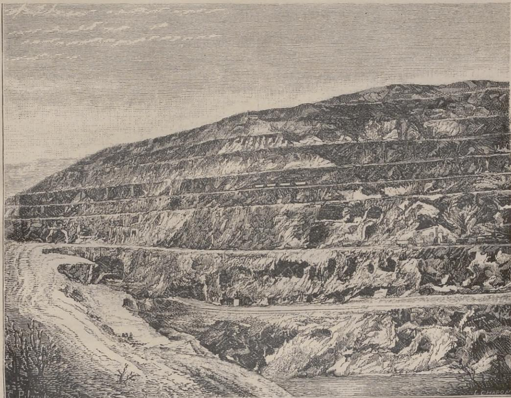
VISTA DE LOS DISTINTOS PISOS DE ARRANQUE DEL MINERAL, Á CIELO ABIERTO
