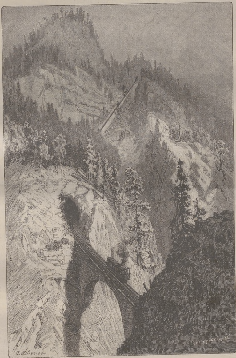
PUENTE DEL BARRANCO DE WOLFORT Y RAMPA DE RISLETEN, CON PENDIENTE DEL 48 POR 100
