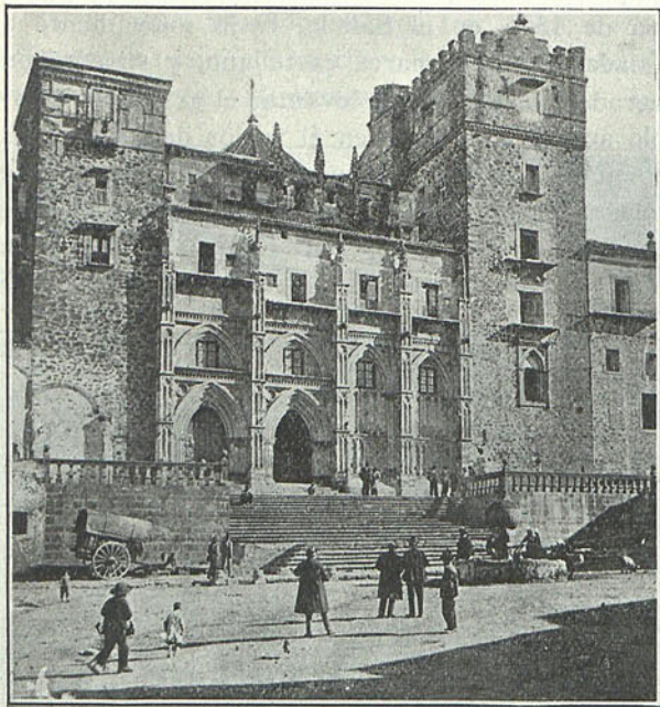
GUADALUPE.—Fachada del Monasterio.
