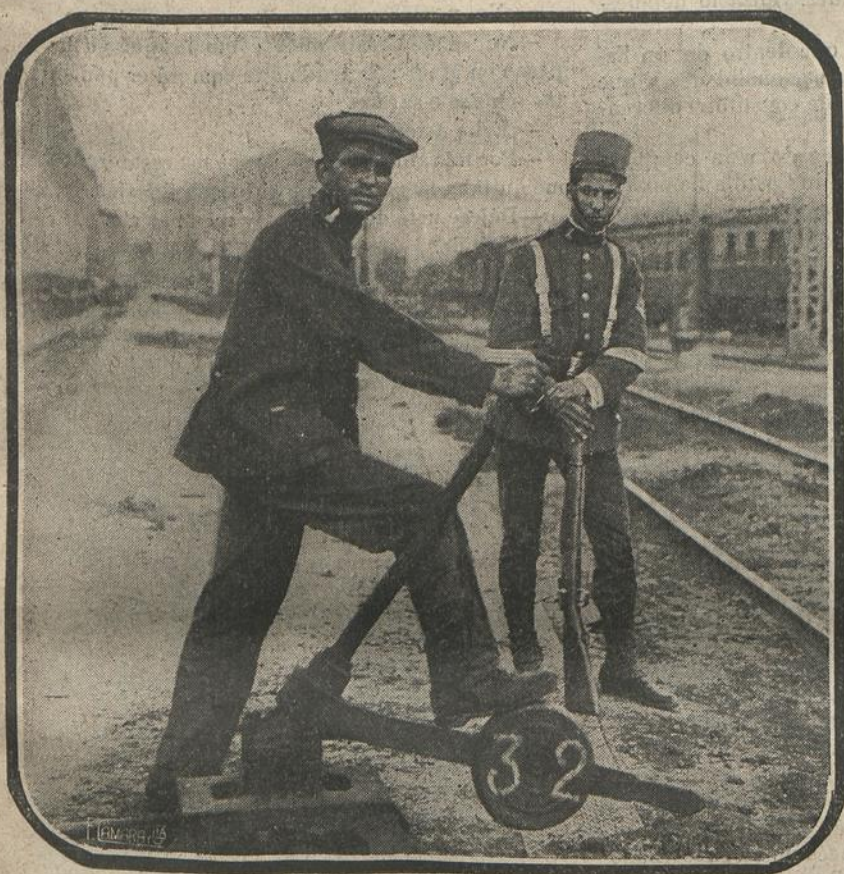
Soldado, empleado en la línea del Norte en el manejo de una aguja, custodiado por un sargento de Ingenieros.
