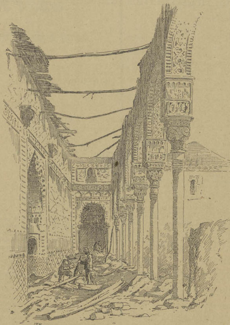
VISTA LATERAL DE LA GALERÍA Y PATIO DE LOS ARRAYANES
