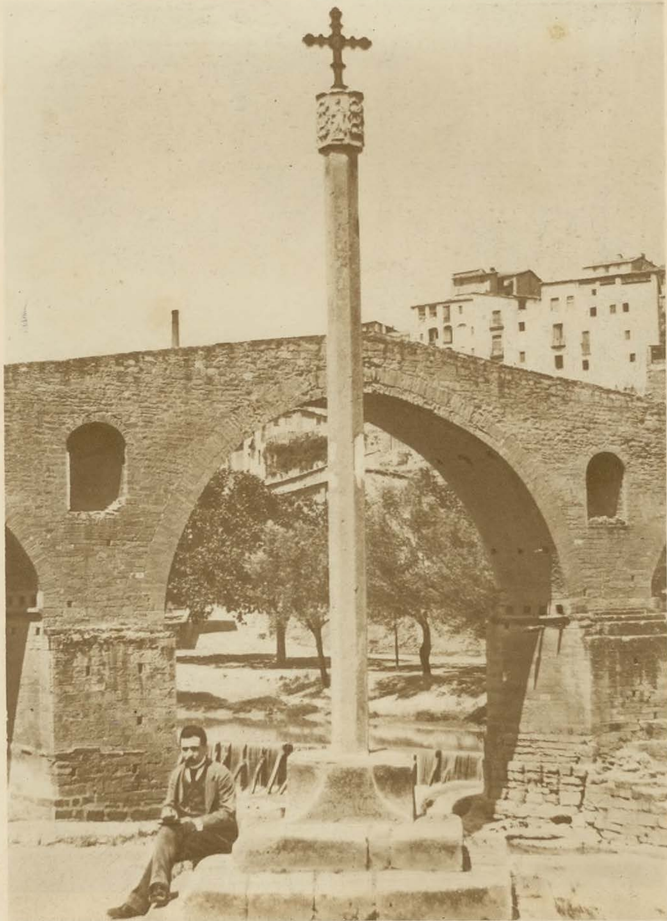
MANRESA : PUENTE ROMANO Y CRUZ DE PIEDRA
