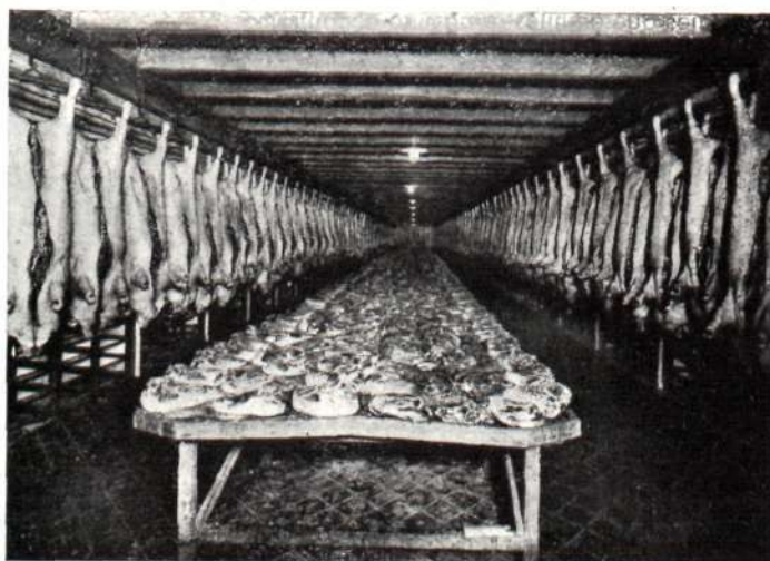
Cámara núm. 1 para el enfriamiento
