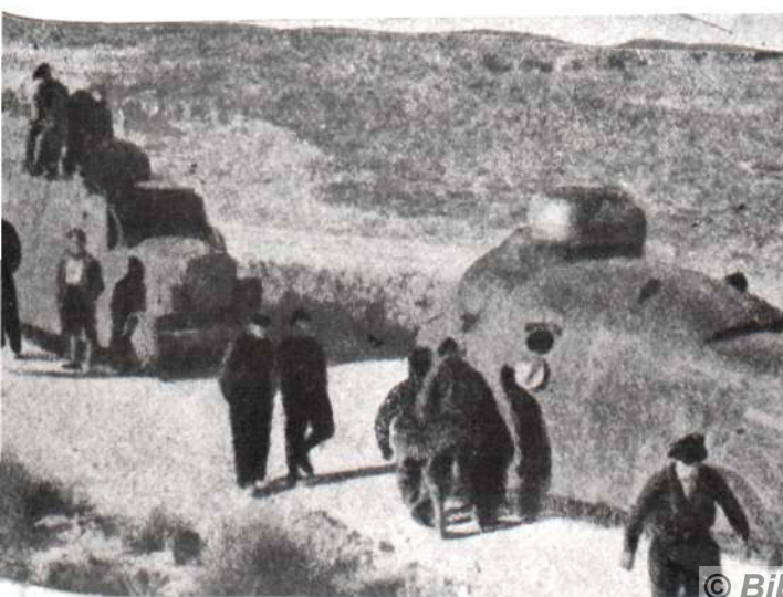
Tanques haciendo la descubierta en el frente de Málaga.
