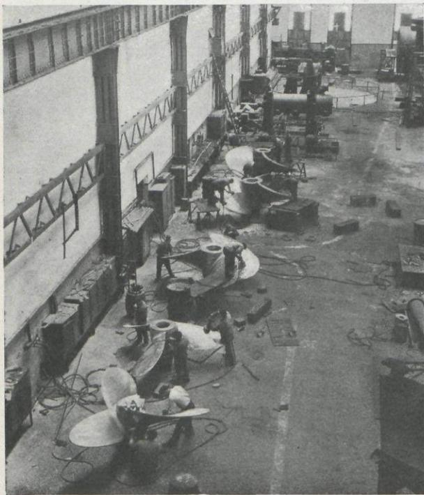
Figura 8.ª—Nave destinada al pulimento de hélices
