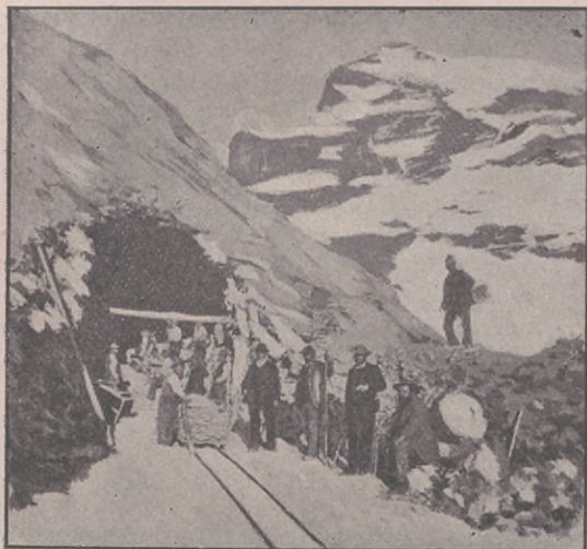
CONSTRUCCIÓN DEL PRIMER TUNEL MÁS ARRIBA DEL GLACIAR DEL EIGER
