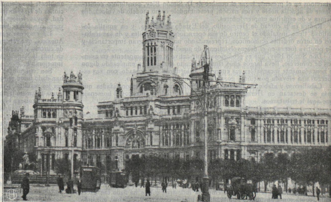
Palacio de Comunicaciones. — Madrid
