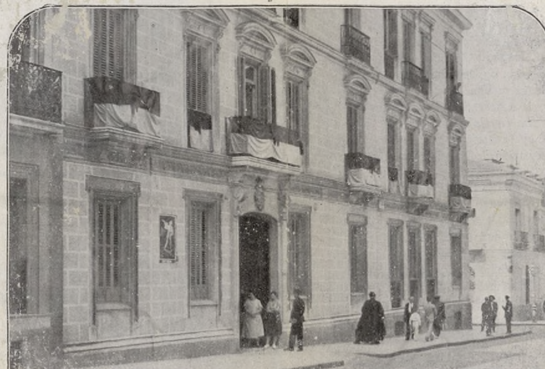
Acenas conocida oficialmente la muerte de don Gonzalo, Renovación Española puso colgaduras con crespones negros en sus balcones
