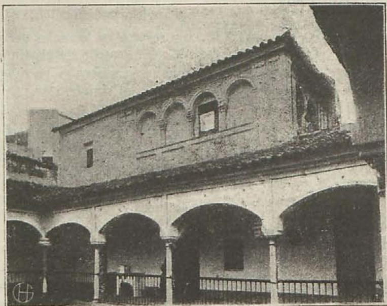
Galería alta y mirador.
