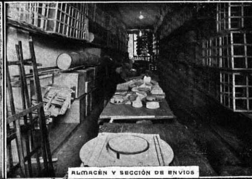
ALMACÉN Y SECCIÓN DE ENVÍOS
