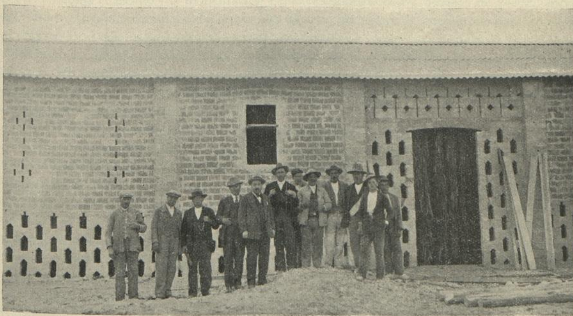
Modelo de secadero con mechinales para la ventilación, construido en Granada.
