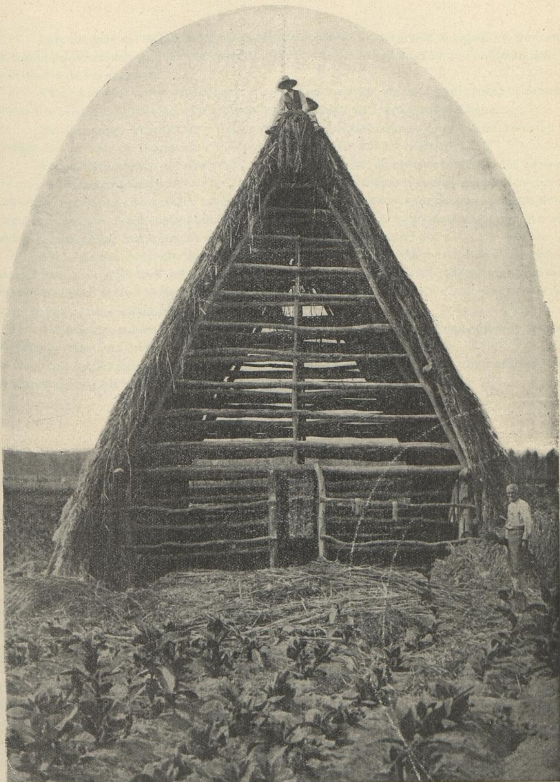
Poniendo la techumbre de enea y palma en el secadero tipo cubano.
