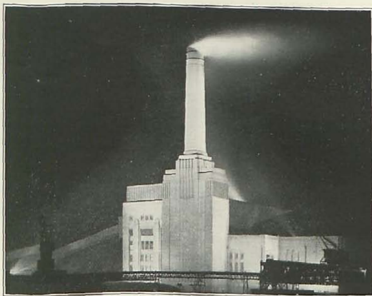
La central eléctrica de Battersea (Londres) cuya capacidad de generación es de 500.000 KW.
