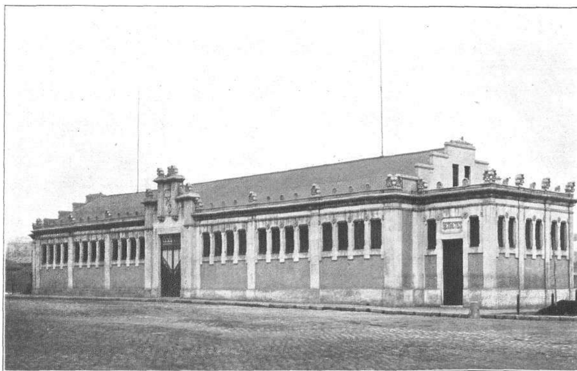
EDIFICIO-PABELLÓN DE HIGIENE Y DISPENSARIO FACHADA PRINCIPAL
