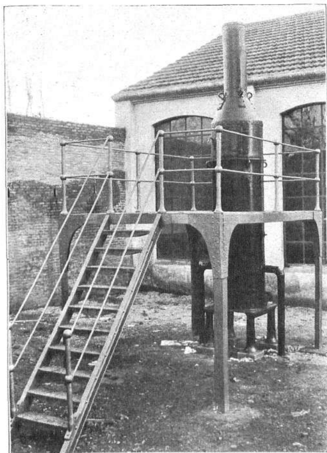
EL «CUBILOTE» DE LA SECCIÓN DE MECÁNICAS
