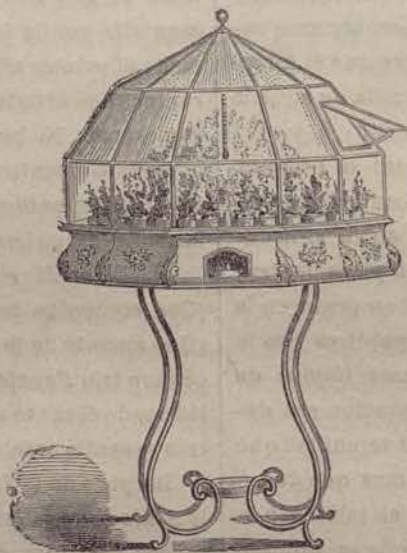
Invernadero de salón.
