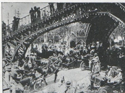
Aspecto de la Pasarela
