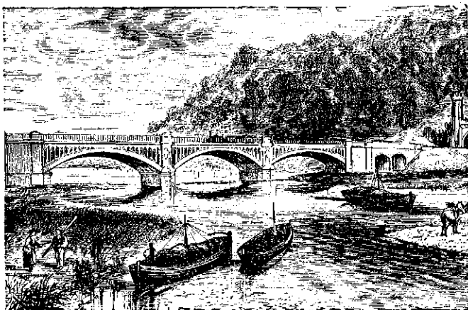
Puente de Worcester.
