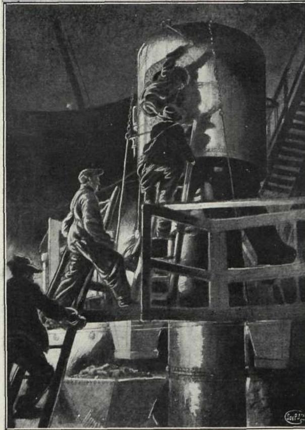
OBROS DESCENDIENDO Á TRABAJAR EN LAS CÁMARAS SUMERGIDAS EN EL RÍO PARA LA CONSTRUCCIÓN DE UN PUENTE
