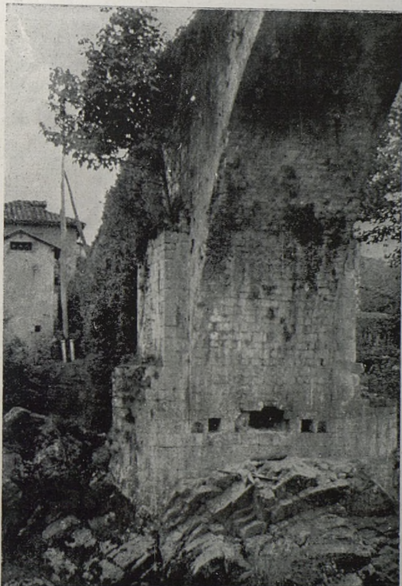
Detalle del arco del puente romano de Cangas de Onís, nótese las cavidades hechas por los rojos para volarle.
