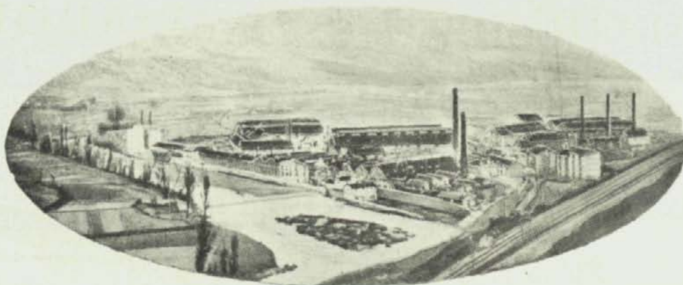
Vista general de la fábrica BASCONIA, en Dos Caminos
