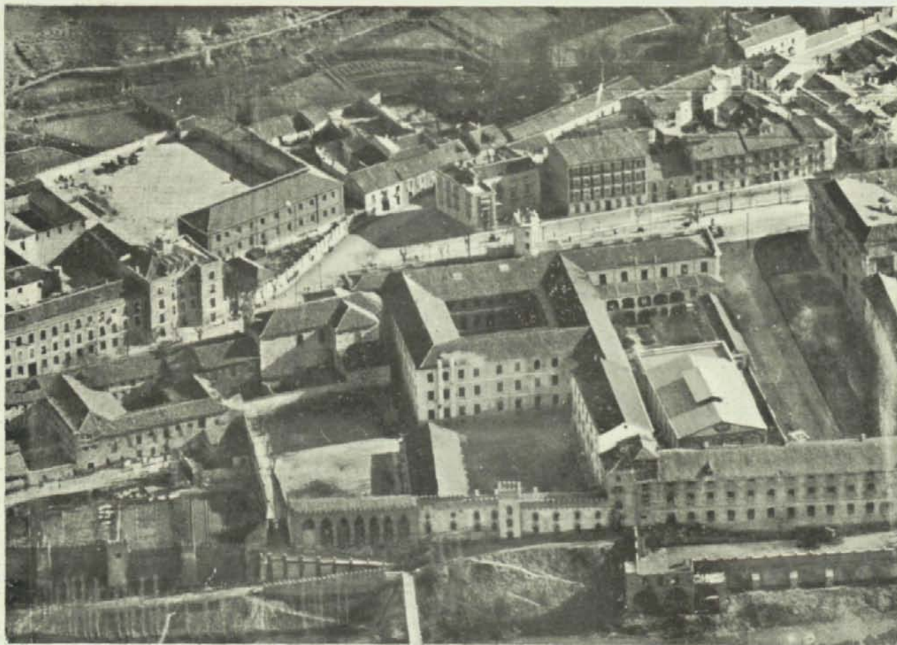
Fotografía aérea del edificio de la Academia de Ingenieros
