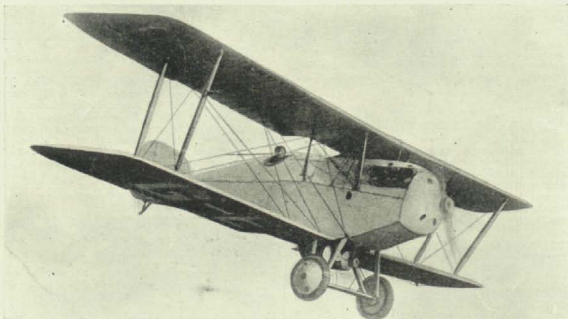
Martinsy de F 4 (A), equipado con 300 HP. Hispano-Suiza y radiador Lamblin.
