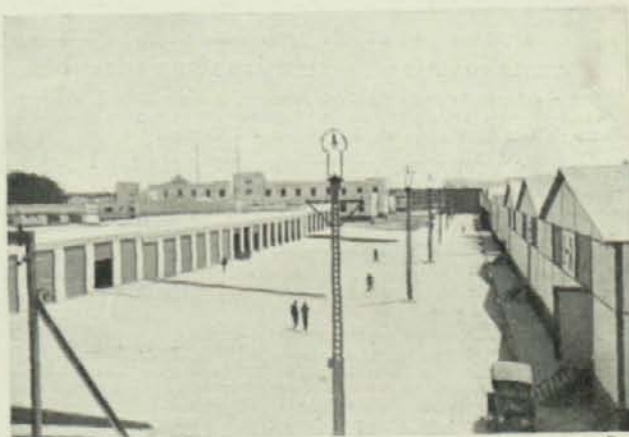
Una calle de la Base aérea de Sevilla. A la izquierda, cocheros de automóviles.
