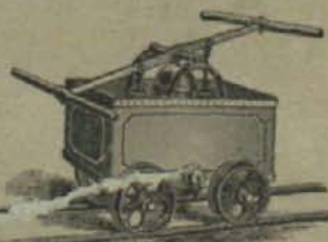
Bomba contra incendios en las minas.
