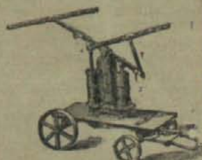
Bomba contra incendios en las plazas.
